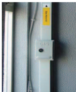
Fig. 4.21 – Exemplo de tubagem colocada em canaleta
