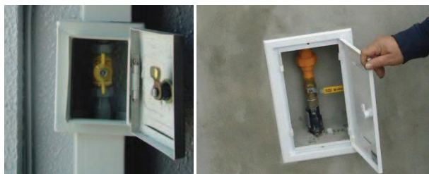
Fig. 4.23 – Exemplos de Caixas de Visita destinadas a alojar uma válvula e a permitir a respectiva inspecção
