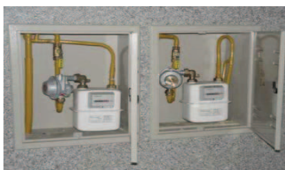
Fig. 4.8 – Contador e redutor de pressão alojado num alvéolo técnico de gás
