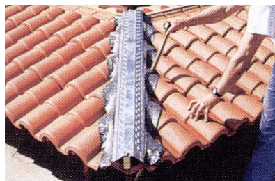
Fig. 82 - Colocação de peças de remates de rincão com banda de ventilação
