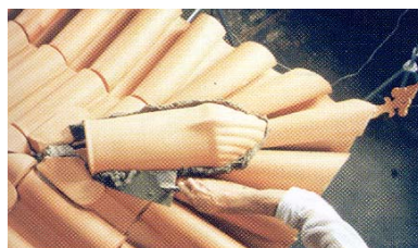
Fig. 95 - Colocação da pata de leão no remate do beirado de canto.
