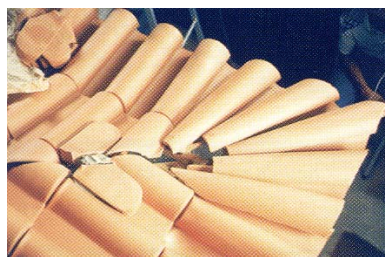
Fig. 94 - Início de colocação das peças do canto de beirado
