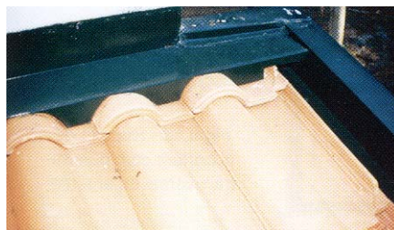
Fig. 91 - Remate com parede transversal com rufo metálico
