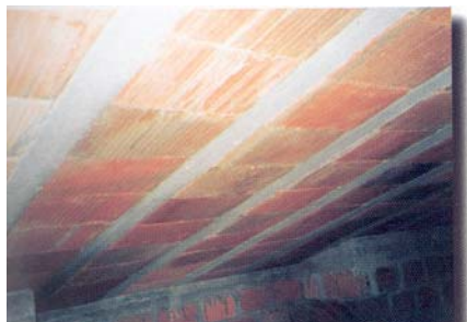
Fig. 46 - Forro rígido em vigotas e abobodilhas cerâmicas
