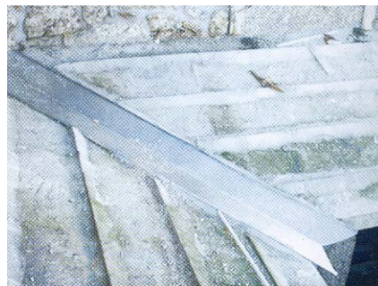
Fig. 85 - Pormenor de construção de laró com rufo galvanizado
