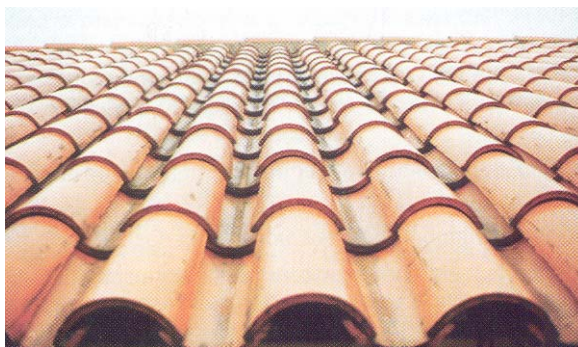
Fig. 48 - Aspecto geral de cobertura inclinada com aplicação de subtelha (de notar a rectilinearidade do conjunto).
