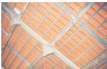
Fig. 44 - Exemplo de aplicação de ripas e varas em perfis metálicos
