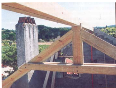
Fig. 52 - Asnas de madeira – aproveitamento arquitectónico com estrutura à vista em acções de reconstrução e reabilitação
