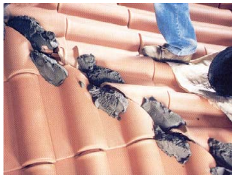
Fig. 81 - Pontos de argamassa para união dos remates do rincão
