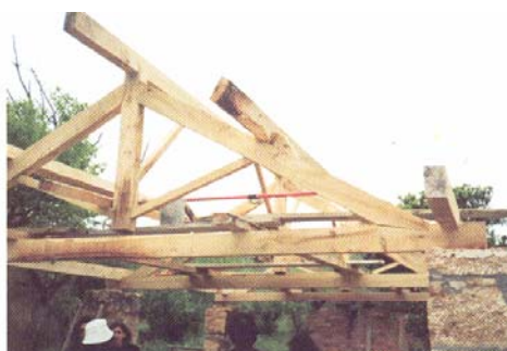
Fig. 51 - Asnas de madeira correntes – durante a construção
