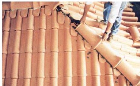
Fig. 84 - Colocação de telhões no rincão com cruzeta
