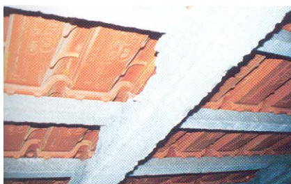
Fig. 45 - Exemplo de aplicação de ripado, assentamentos incorrectos das telhas.
