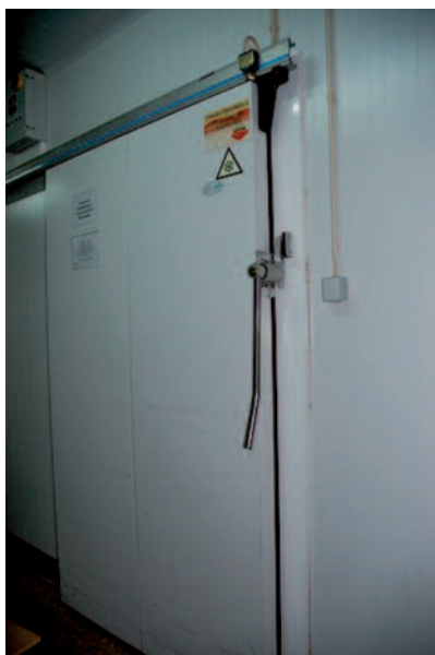
FIGURA 49 Arca frigorífica de conservação carne (Temperatura +/- 2°C)
