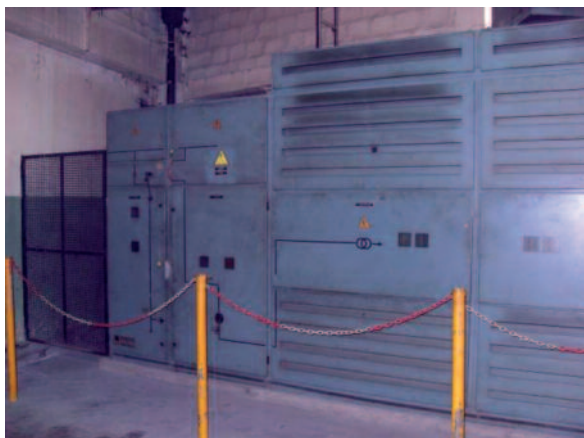
FIGURA 108 Posto de transformação em cabine metálica (monobloco)
