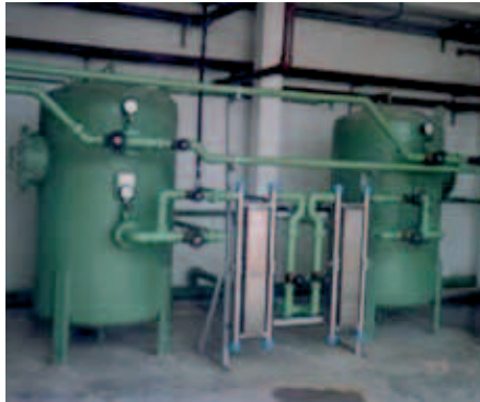
FIGURA 57 Sistema de desinfecção de água por radiação ultravioleta
