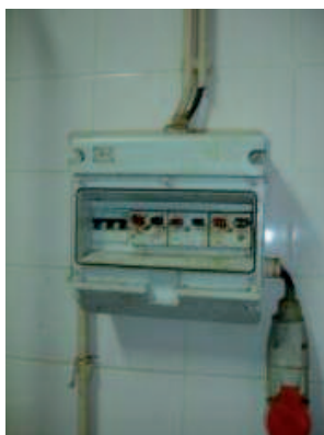
FIGURA 116 Quadro eléctrico sem porta e sem identificação dos dispositivos de corte
