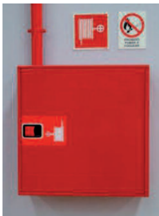
FIGURA 151 Exemplo de um armário com uma boca-de-incêndio armada de 25 mm
