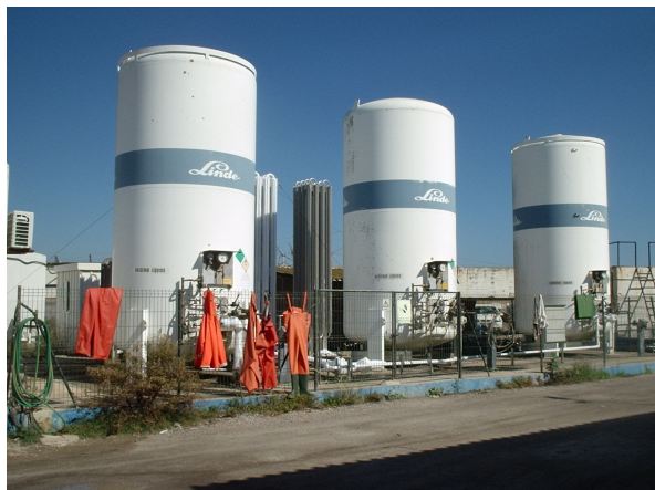
Figura 19- Sistema de armazenamento de oxigénio líquido
