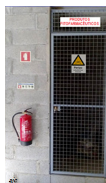
Armazenamento seguro para explorações de média a grande dimensão - mecanismos de fecho que impeçam o acesso a crianças, ventilados, sinalizados, com piso impermeável e com extintor. | Fonte: DGAV
