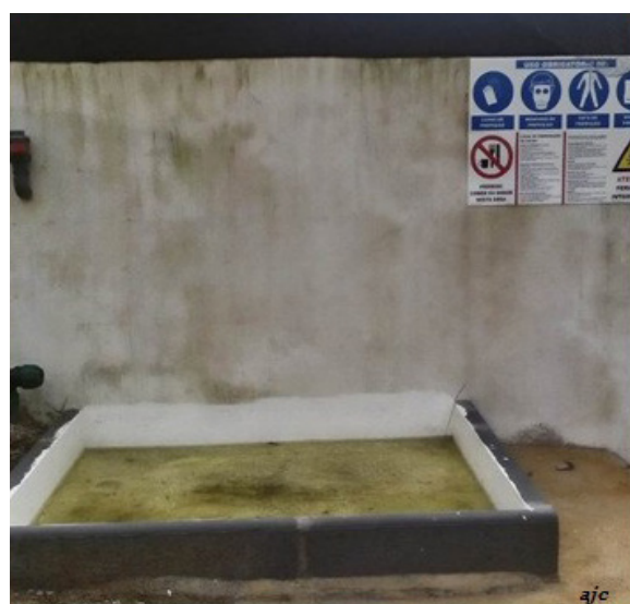
Zona de preparação da calda (impermeável e com depósito de recolha) Fonte: Jorge Carvalho
