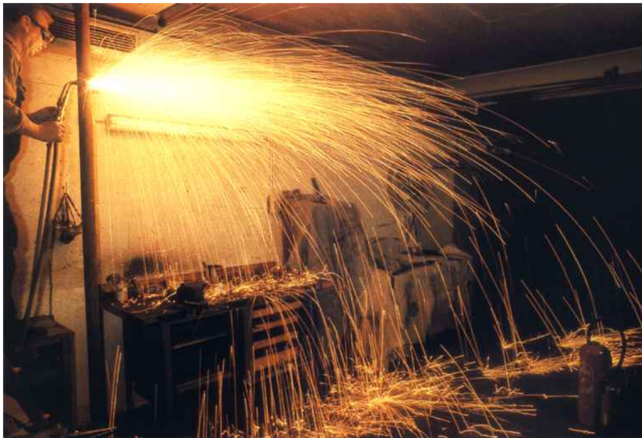
Figura 1 – Projecção de partículas incandescentes em trabalhos de oxicorte – as instalações e materiais de natureza combustível, bem como as aberturas em paredes, foram protegidas com materiais resistentes ao fogo.
