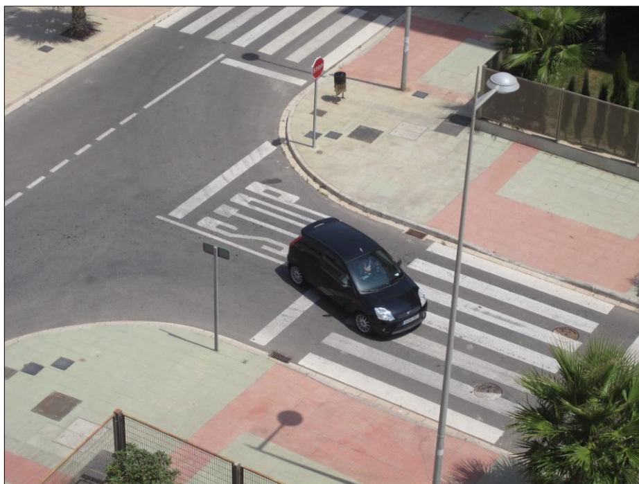
Figura 5 Rua local num novo desenvolvimento em Almeria (Espanha). A concepção da rua segue padrões tradicionais, onde, quer a rua e os sinais são idênticos às ruas principais. As velocidades podem ser elevadas mesmo quando se curva (como é demonstrado na figura acima) e os peões só podem atravessar nos locais que lhes são destinados.
