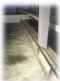
Após a pré-oxidação, a água é doseada com sulfato de alumínio. A adição deste reagente permite a agregação das partículas em suspensão, facilitando a sua separação nas etapas de tratamento subsequentes. Graças ao perfil hidráulico da instalação, a mistura
