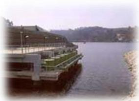
A água é captada na albufeira de Crestuma-Lever por grupos de elevação submersíveis e encaminhada para um reservatório de água bruta. A cota da superfície da água neste reservatório é suficiente para permitir que
