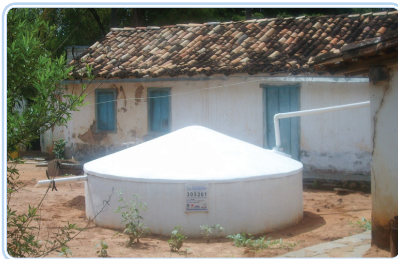
Figura 2: Cisterna de Placas construída através do Programa Um Milhão de Cisternas Rurais - P1MC na comunidade de Roda D'água, Município de Januária, MG, Semiárido Mineiro.
