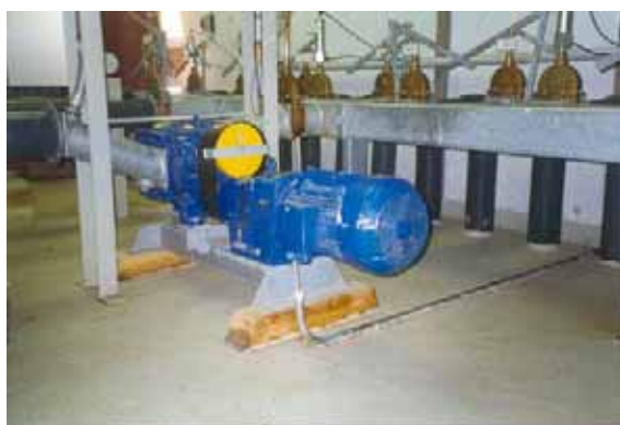
Figura 3.15 - Tubagem para transporte do substrato
