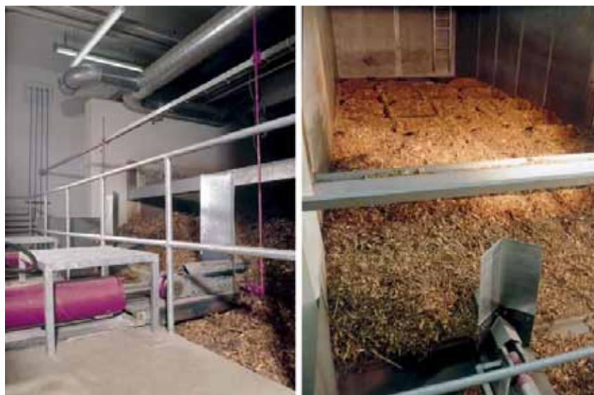
Figura 6.7 – Depósito de combustível com sistema hidráulico de arrastamento
