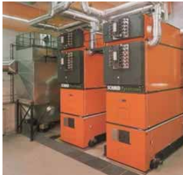
Figura 2.25 - Queimador moderno de madeira 2 x 3,2 MW
