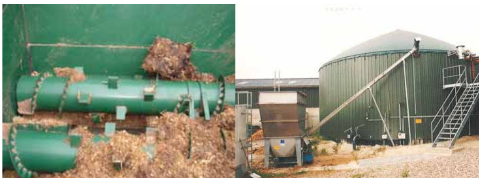
Figura 3.20 - Sistema de alimentação de co-substrato
