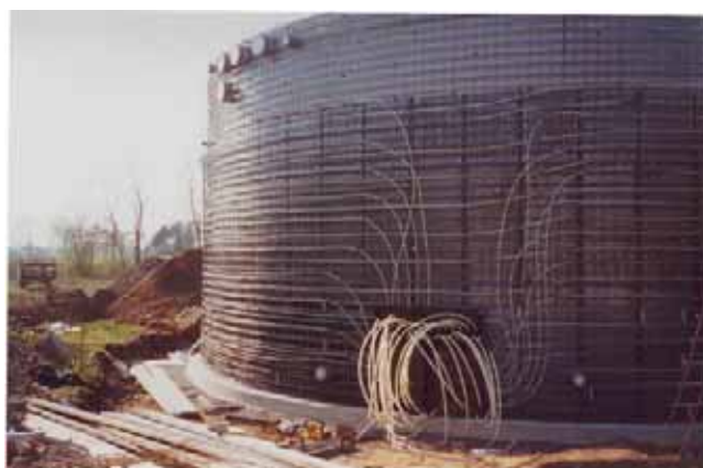
Figura 3.13 – Sistema de aquecimento do digestor
