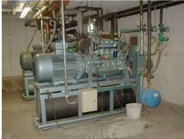
Figura 2.67 - Sistema de cogeração de injeção a diesel com 100 kWe de energia
