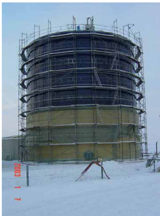
Figura 3.14 - Isolamento térmico do digestor
